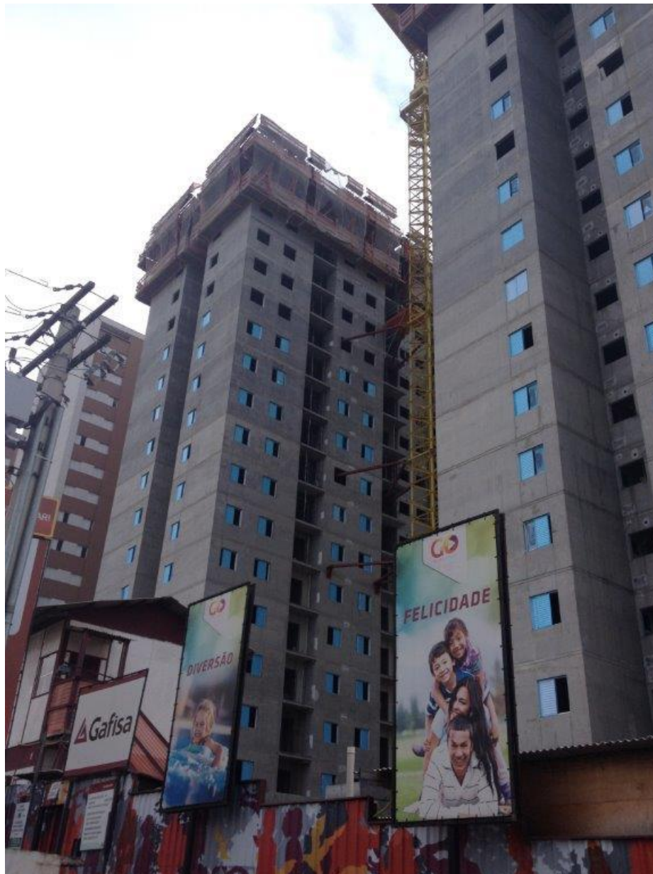
Maraville – Jundiaí Projeto em paredes de concreto
