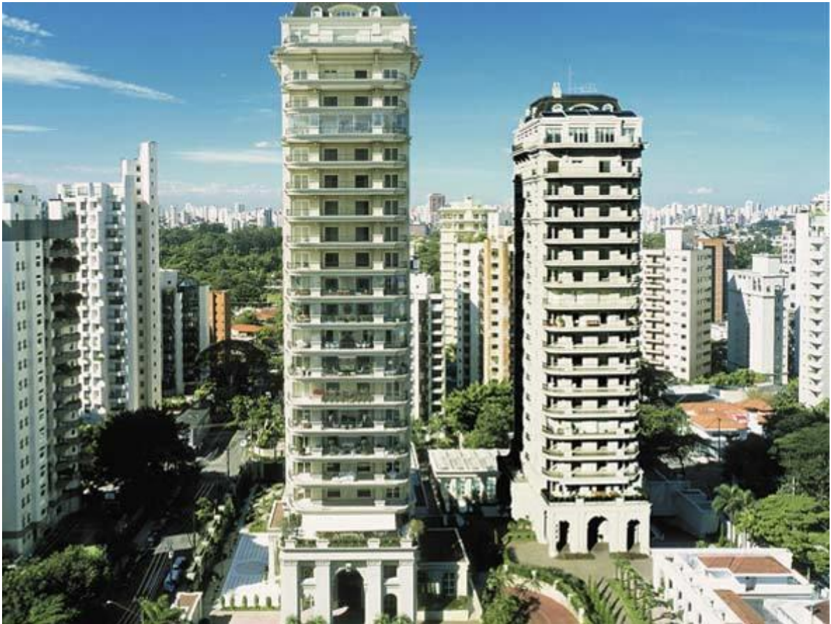
. Edifício Chateau Margaux
